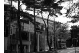
2006（平成18）年 新1号館完成写真
