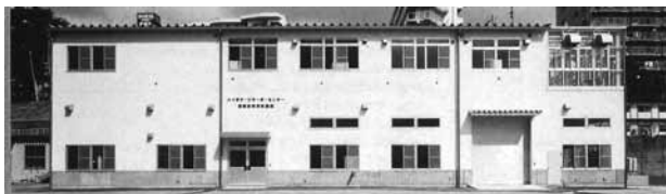
ハイテク・リサーチ・センター完成
