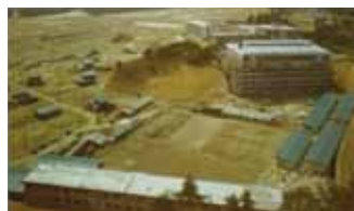
5号館建設中(1968年)
