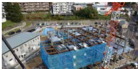
工事の様子【2021年11月1日現在】
