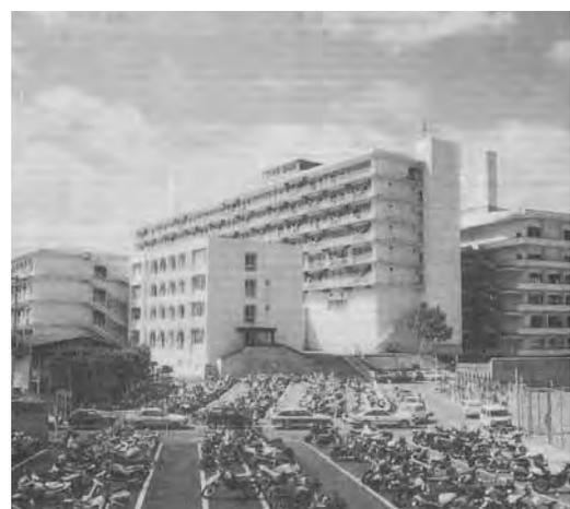
1983（昭和 58）年 2 月 20 日、7 号館が耐震建築として世界初の PC トラス工法で完成。
