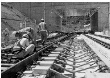
東北新幹線試運転を控えての工事
