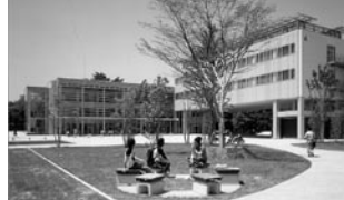
（株）阿部和工務店が建設した本学新一号館全景
