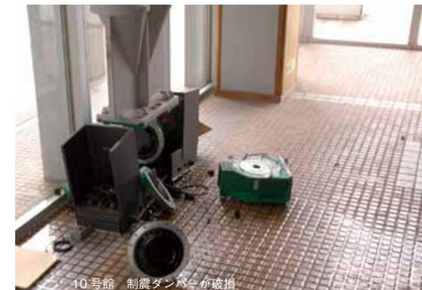
10号館 制震ダンパーが破損
