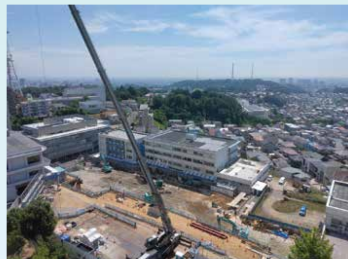
解体工事が進む「5号館」
